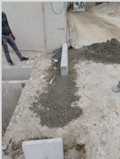
Ugradnja skošenog (glatkog) cestovnog rubnjaka dimenzija 100 x 18 x 24 cm u pogonu tvornice Beton – Lučko RBG d.o.o.
