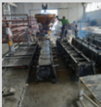
UGRADNJA BETONA U KALUPE
