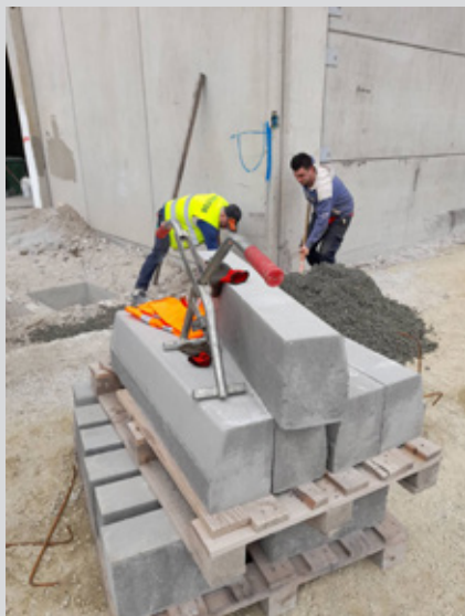
Ugradnja skošenog (glatkog) cestovnog rubnjaka dimenzija 100 x 18 x 24 cm u pogonu tvornice Beton – Lučko RBG d.o.o.
