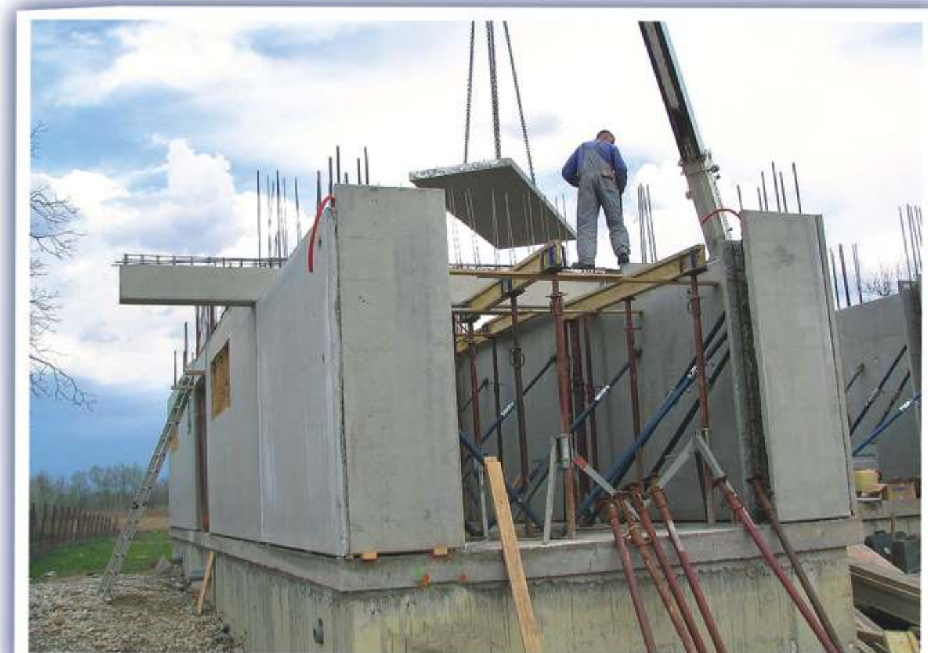
Montaža kranom dizalicom ili autodizalicom.
