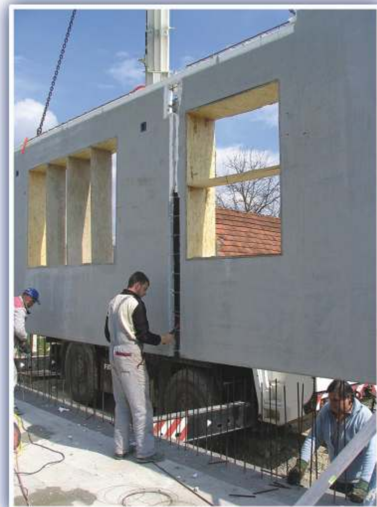
Montaža kranom dizalicom ili autodizalicom.
