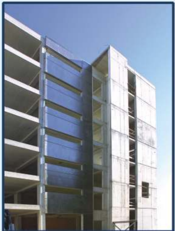
-troslojni a.b. fasadni elementi sa završnom obradom "LOTUS" efekt.
