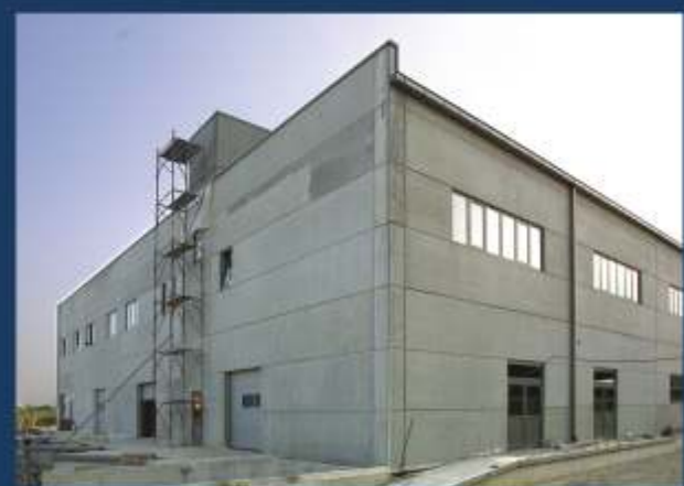
-troslojni a.b. fasadni elementi -pekara Zapreši
