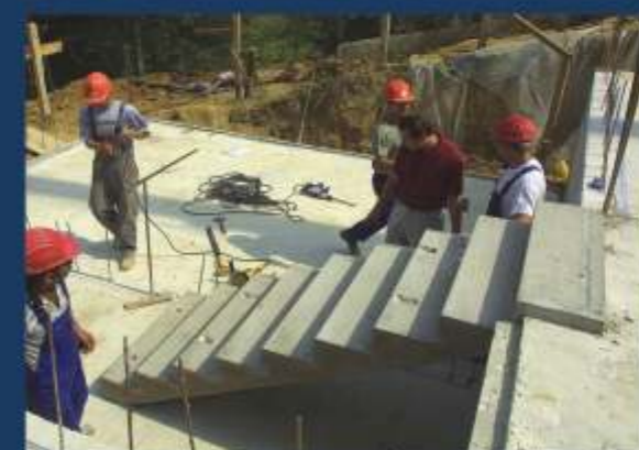
-ugradnja a.b. stubišnih krakova
