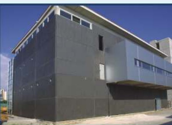
NIN Elektrocommerce, Zadar
