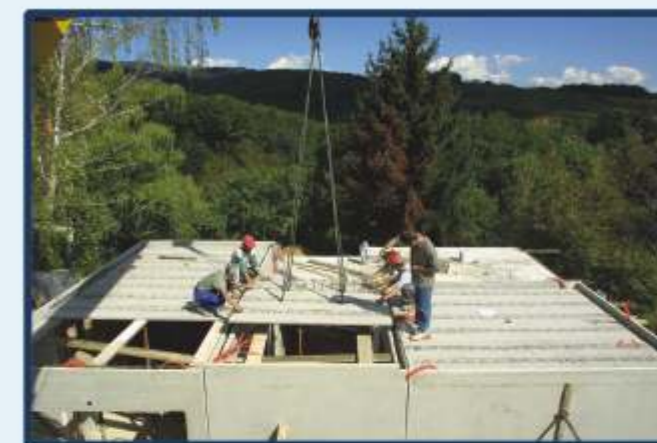
-na in prijevoza i ugradnja stropnih ploča tip: "Omnia".
