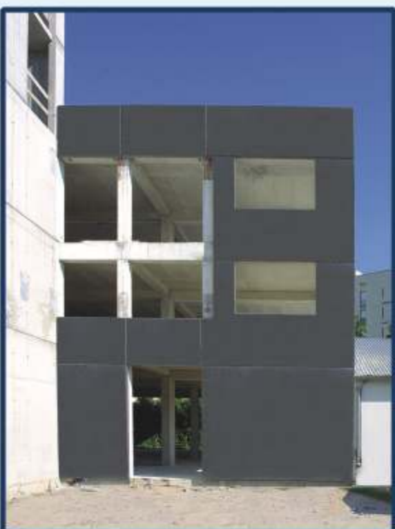
-troslojni a.b. fasadni elementi sa završnom obradom "LOTUS" efekt.
