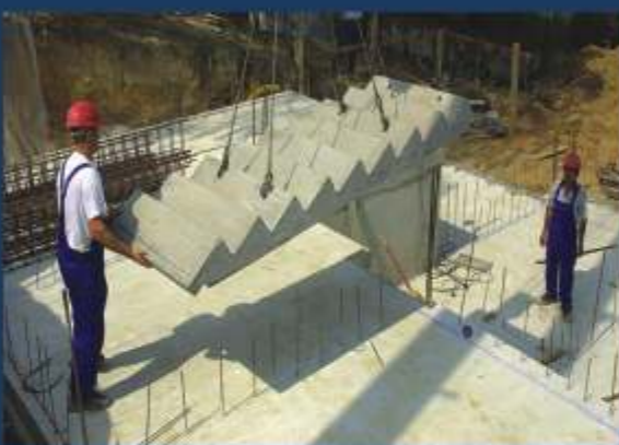
-prijevoz i montaža a.b. stropnih ploča tip: "Omnia"
