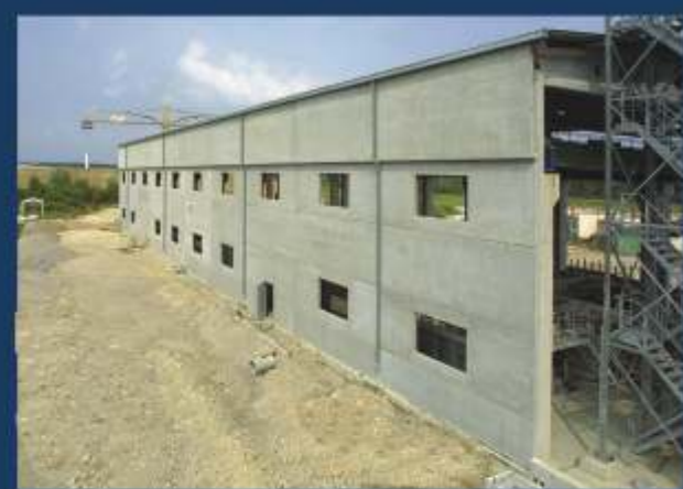
-jednoslojni a.b. fasadni elementi od lakog betona -pogon Betona Lu ko u Karlovcu
