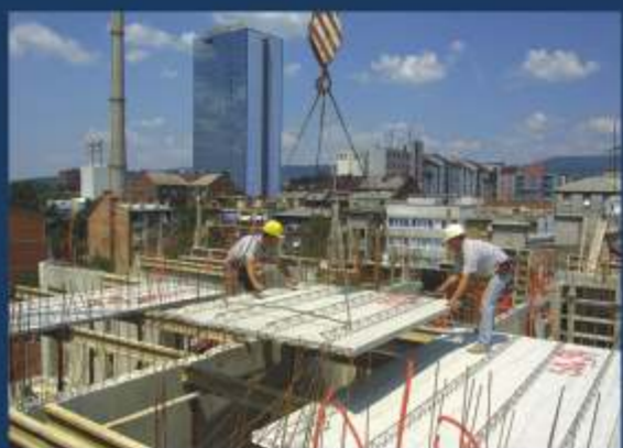
-prijevoz i montaža a.b. stropnih ploča tip: "Omnia"
