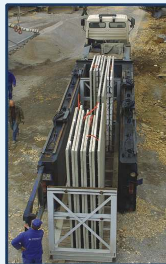
-na in prijevoza i ugradnja stropnih ploča tip: "Omnia".
